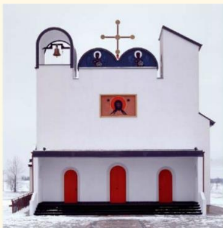
Cerkiew projektu Jerzego Nowosielskiego i Bogdana Kotarby
